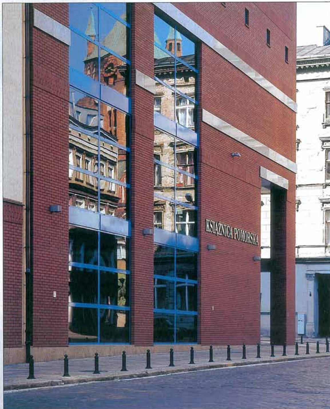
Wśród starej zabudowy stanął ostatnio nowy przeszklony budynek Książnicy Pomorskiej The new building of Pomeranian Library has recently been built among old structures Neulich ist unter die alte Bebauung ein neues modernes verglastes Gebäude der Bibliothek Książnica Pomorska hinzugekommen
