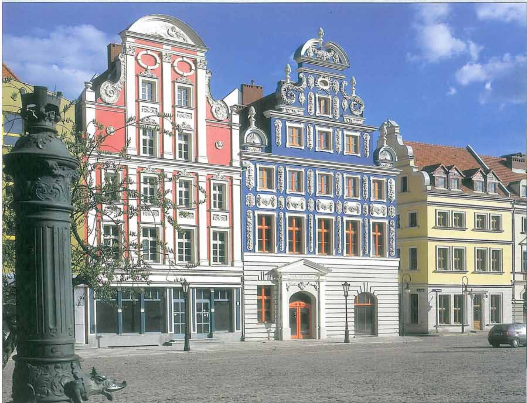
Zrekonstruowane barokowe kamienice przy ul. Siennej 7 i 8 Reconstructed Baroque houses at 7 and 8 Sienna Street Rekonstruierte Barockhäuser in der Sienna-Str. 7 und 8
