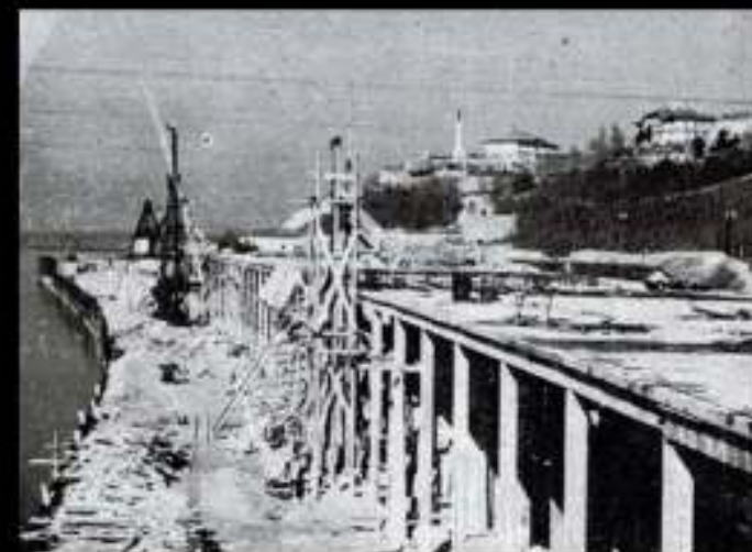
Beton hala u periodu izradnje
