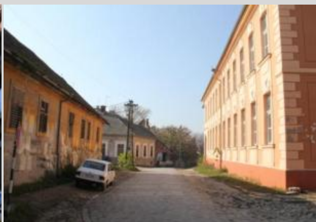
ulica Djure Jakšića pred rekonstrukciju
