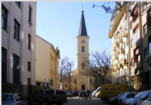
ulica Štrosmajerova pred rekonstrukciju
