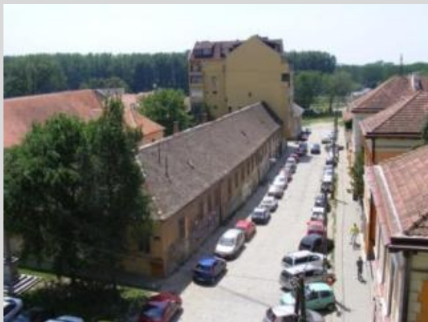
ulica Ignjata Barajevca pred rekonstrukciju
