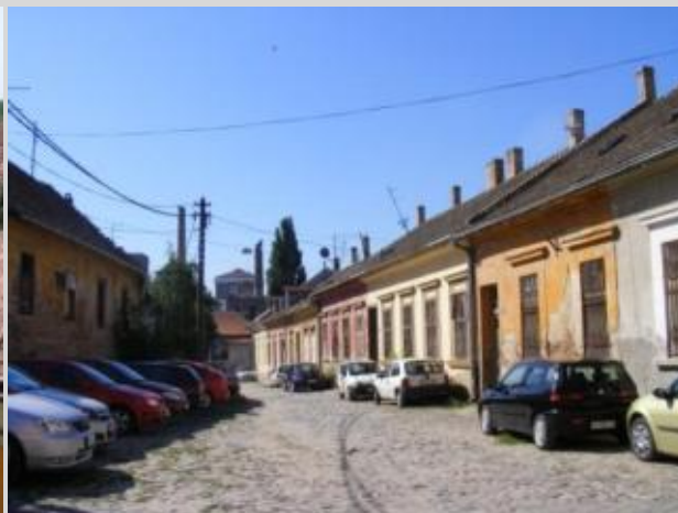
ulica Nikole Đurkovića pred rekonstrukciju
