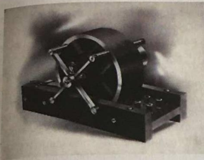
Теслин двофазни индукциони мотор који је први пут демонстрирао на Колумбија универзитету 1888. године.
