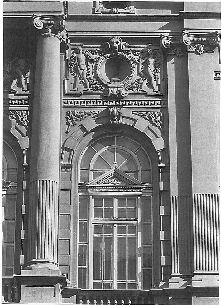
Сл. 6. Фасада-детал прозора (фото: С. Неговановић, сарадник Завода)
