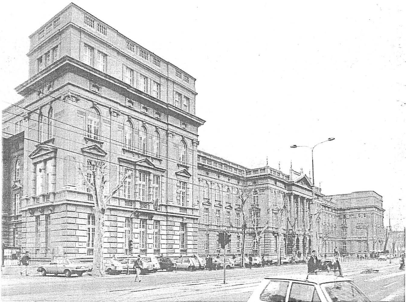
4 Фотографија зграде после рестаураторских радова
